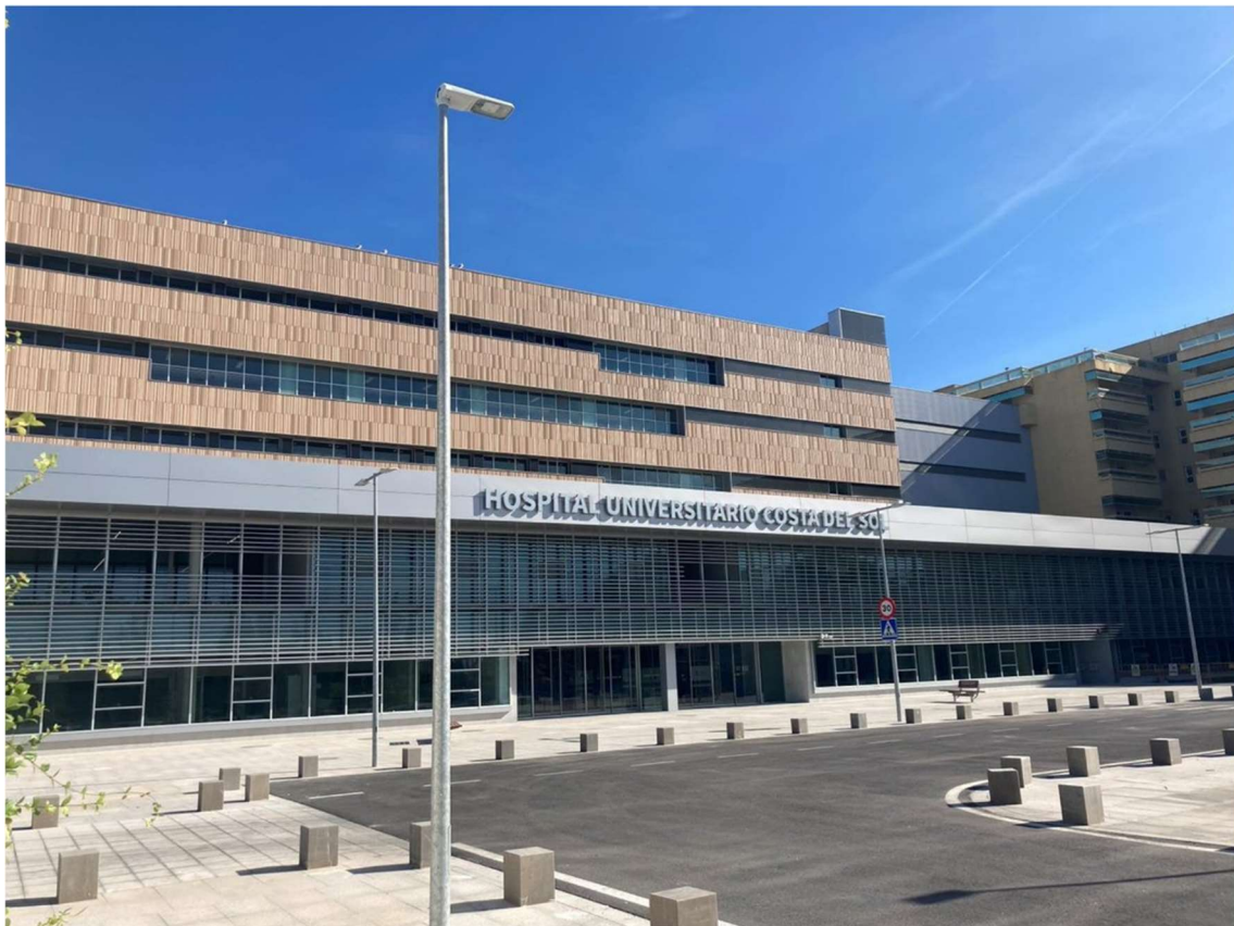
Ilustración 2 Entrada al edificio B del Hospital Universitario Costa del Sol (parte de la ampliación)
